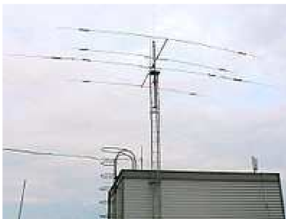
Antena direccional de 4 elementos, propiedad de la Universidad técnica Braunschweig (Foto: DG6XU).
