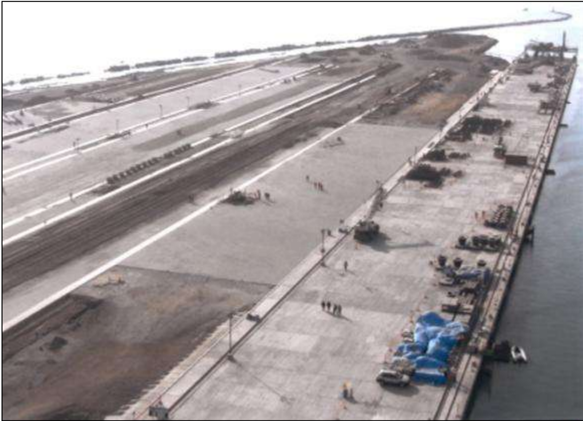
Figura 56. Foto actual de la construcción del Muelle Sur
