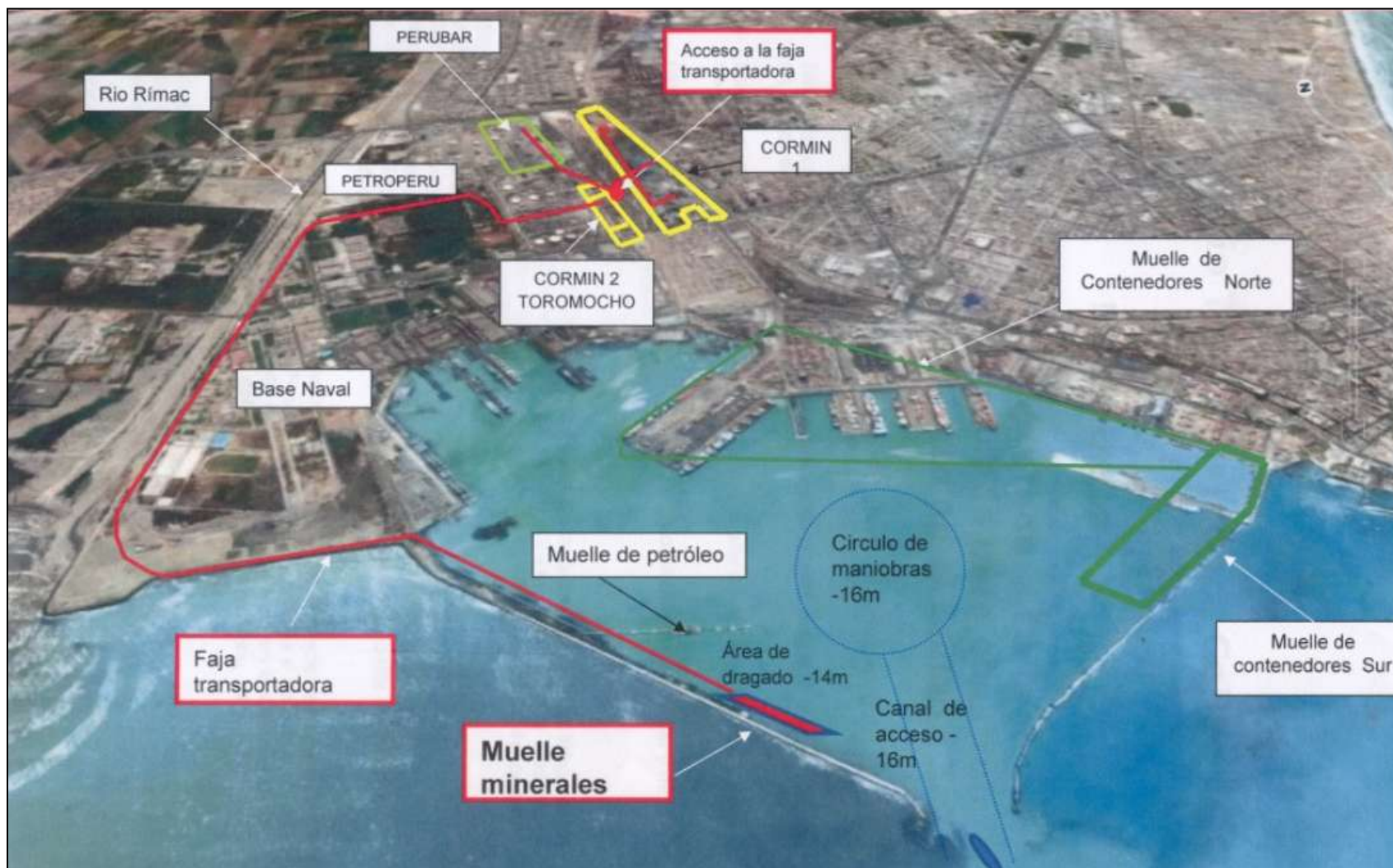
Figura 57. Vista general del proyecto.
