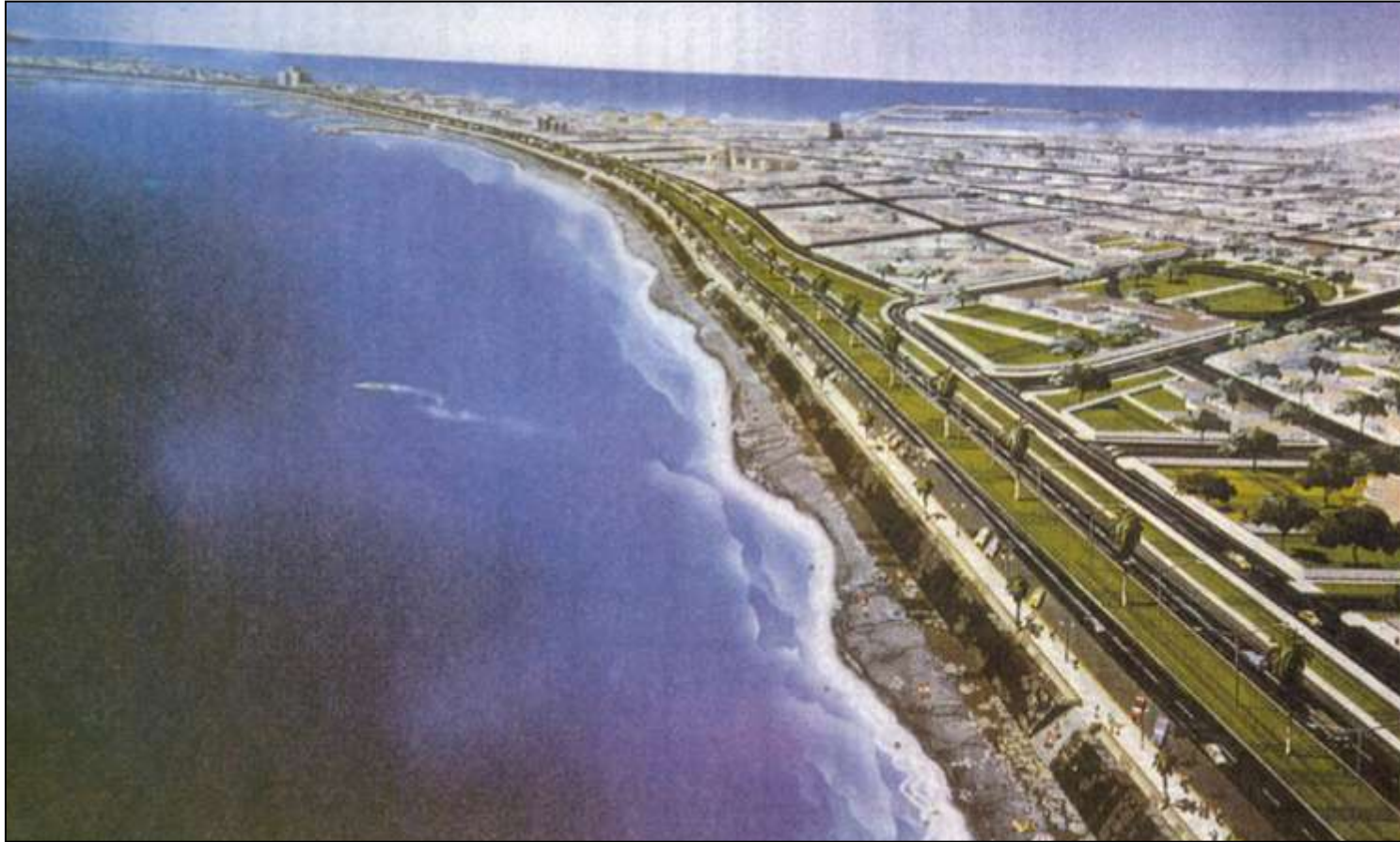
Figura 40. Vía Costa Verde – Tramo Callao.
